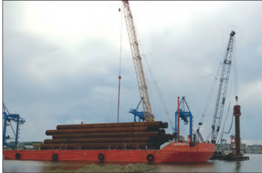
Palowanie przed budową nowego nadbrzeża w DCT w Gdańsku (fot. DCT).
